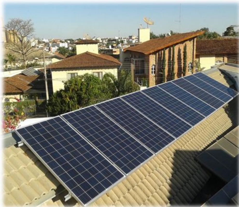
Instalação de Energia Solar Residencial em Uberaba – MG
